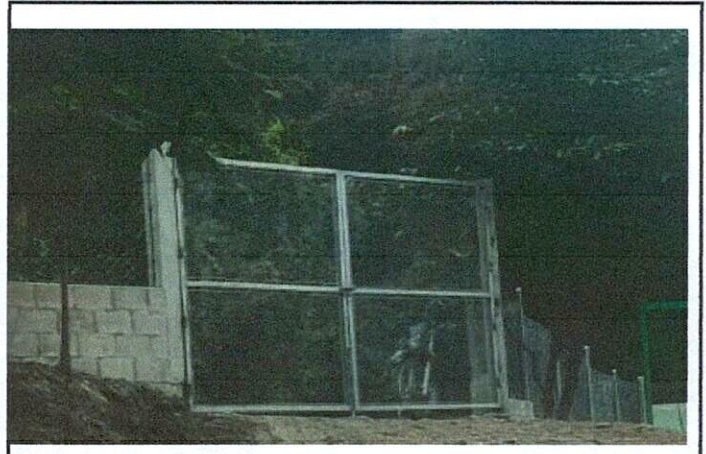
Foto 4: Mejoramiento del portón
