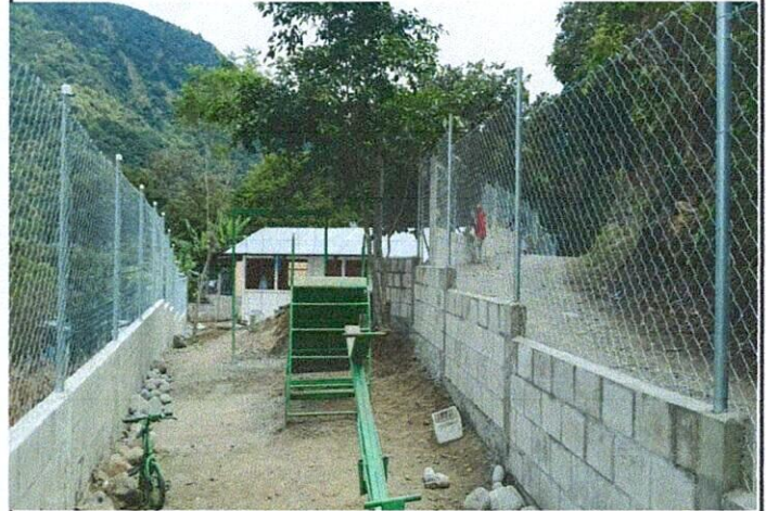
Foto 2: Mejoramiento del cerco perimetral.
