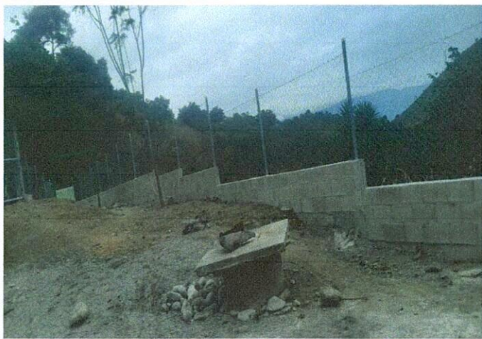
Foto1: Mejoramiento del cerco perimetral.
